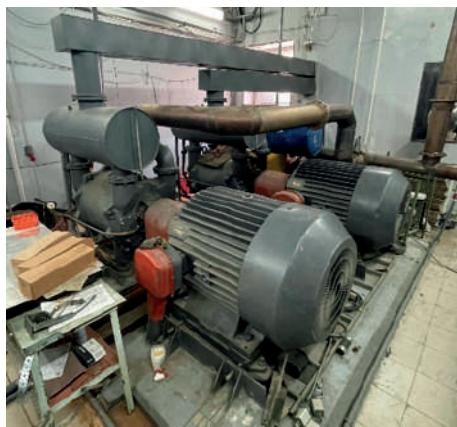
Рис. 3. Восстановленная вакуумная магистраль
