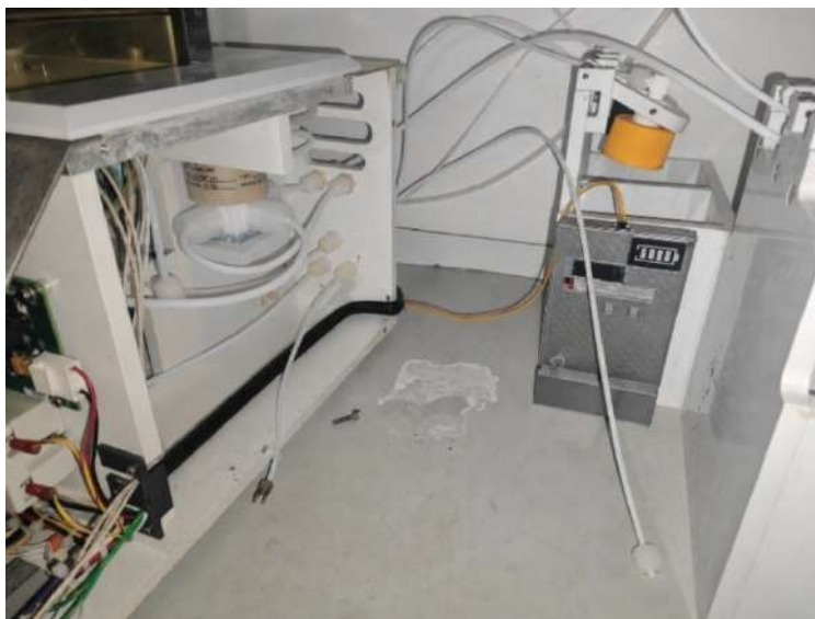
Рисунок 93 – Размещение сенсора утечек углеводородных жидкостей в зоне установки JetEtch Pro
