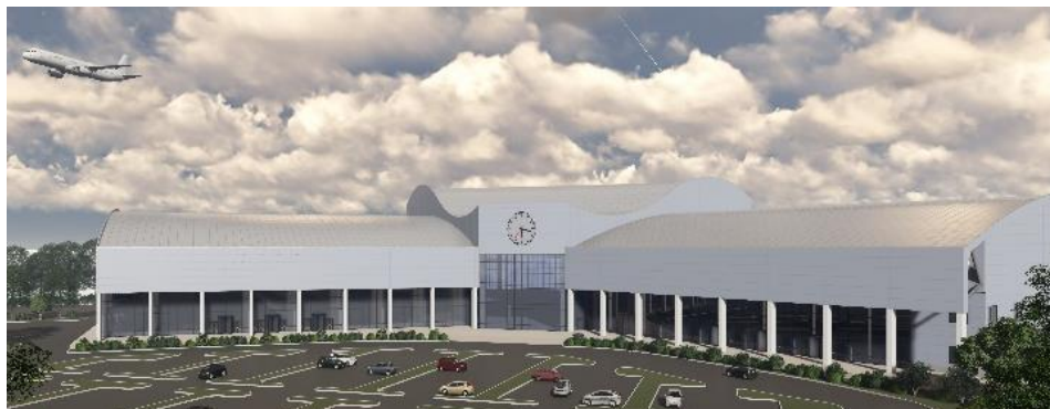
Рис. 2.14. Главный фасад исследуемого здания с покрытием из криволинейных ферм
