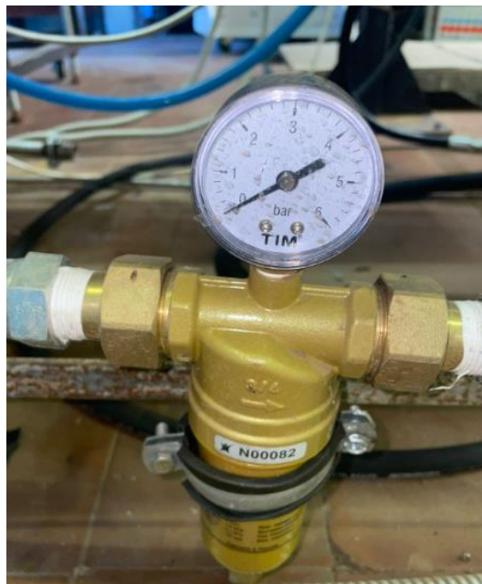
Рисунок 2.1.3 Фильтр грубой очистки CITY FM-A06-C \frac{3}{4}
