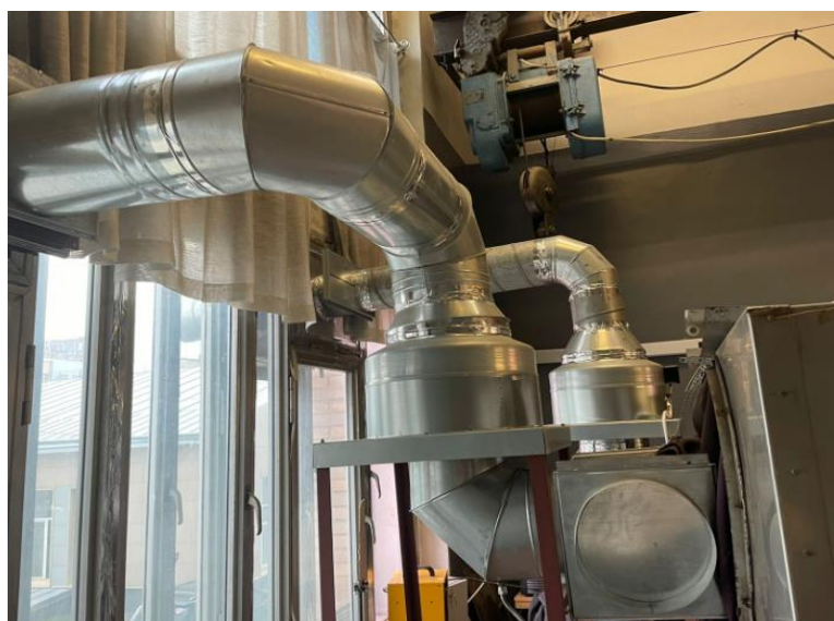
Рисунок 2.1.14 Система с вентилятором удаления отсепарированного воздуха
