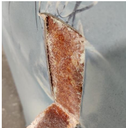
Рисунок 4.10 — Отслоение обшивки стенки обтекателя
