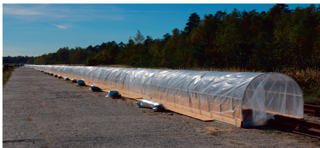
Рис. 1. Фотография галереи, сооруженной над правым рельсом трека
