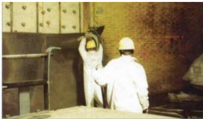
Рисунок 1.11 – Нанесение бетонного ТЗП методом торкретирования в космическом центре им. Кеннеди
