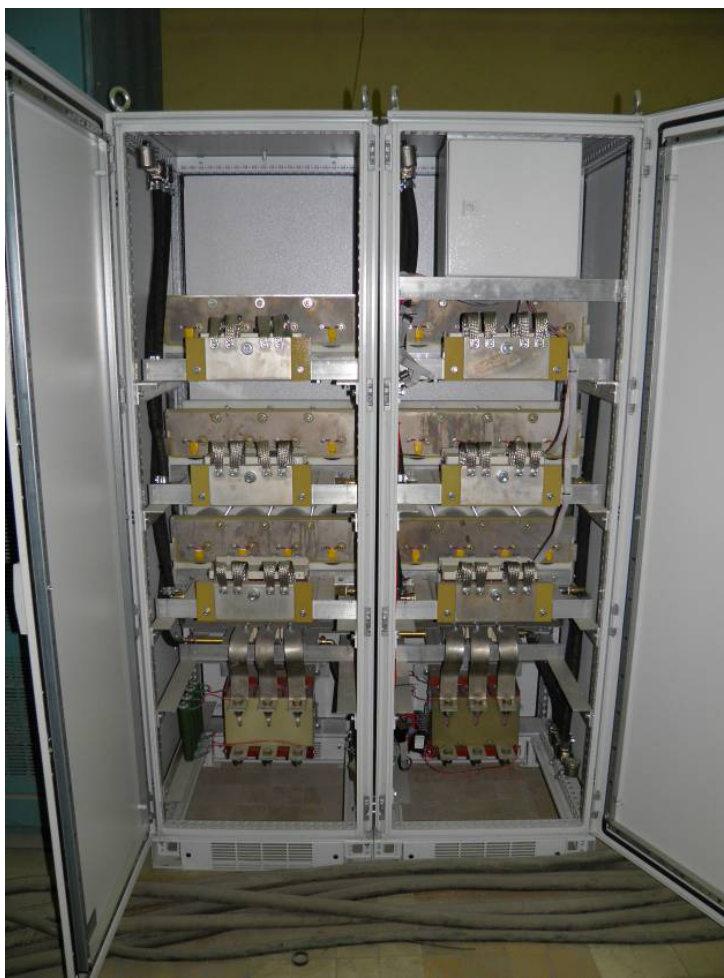
Рисунок 6.1. Тиристорный преобразователь с водяным охлаждением для питания привода генератора
