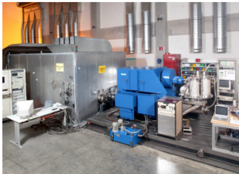
Рисунок 1.13. Генератор мощностью 4 МВА с обмотками возбуждения из ВТСП 1G на испытательном стенде (фирма «Siemens», Германия)
