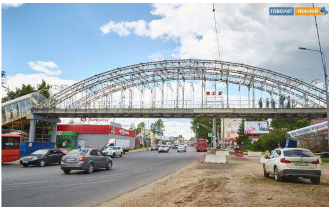
Рисунок 5.25 – Сварной алюминиевый надземный пешеходный переход (а) и силовая балка моста (б) выполненная сваркой трением с перемешиванием. Пешеходный мост (в) через федеральную трассу М-7 «Волга».
