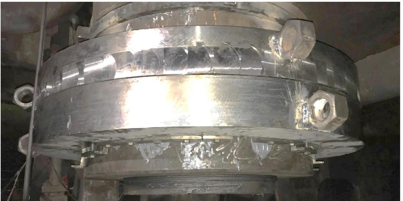
Рисунок 77.Бандаж, установленный на гайку колонны с поврежденной резьбой во время проведенного восстановительного ремонта в 2018 г.
