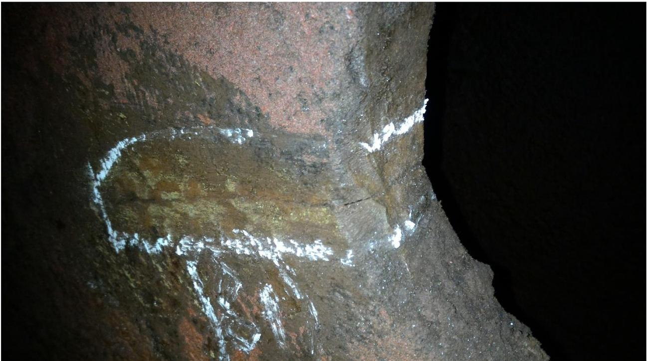
Рисунок 1. Фотография одной из обнаруженных трещин пресса №206 СМЗ
