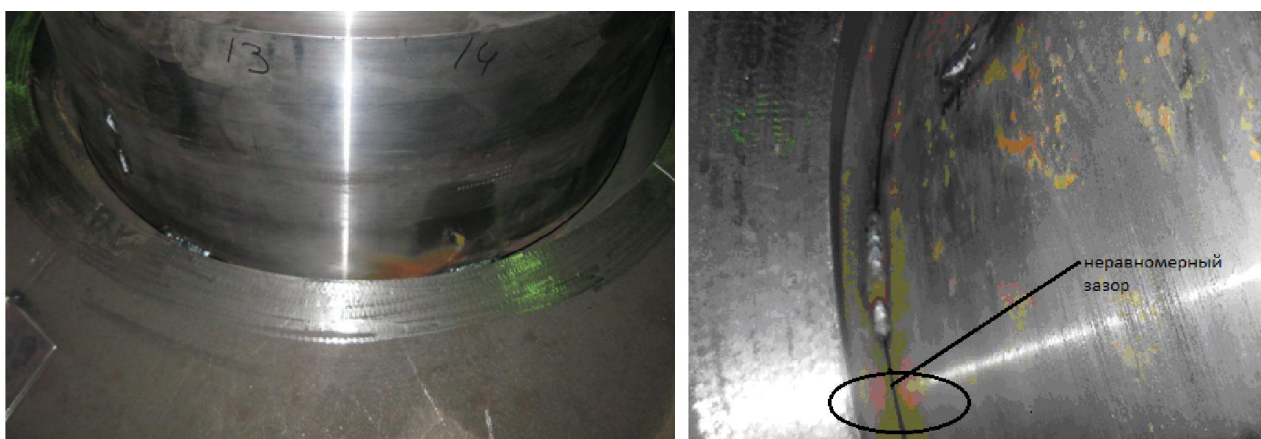
Рис. 6.10. Сварное соединение патрубка фланца с крышкой резервуара
